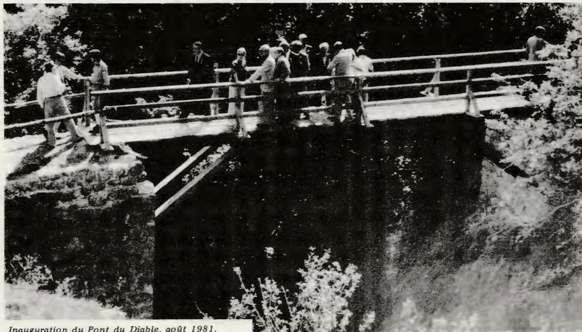
Inauguration du Pont du Diable, août 1981.
