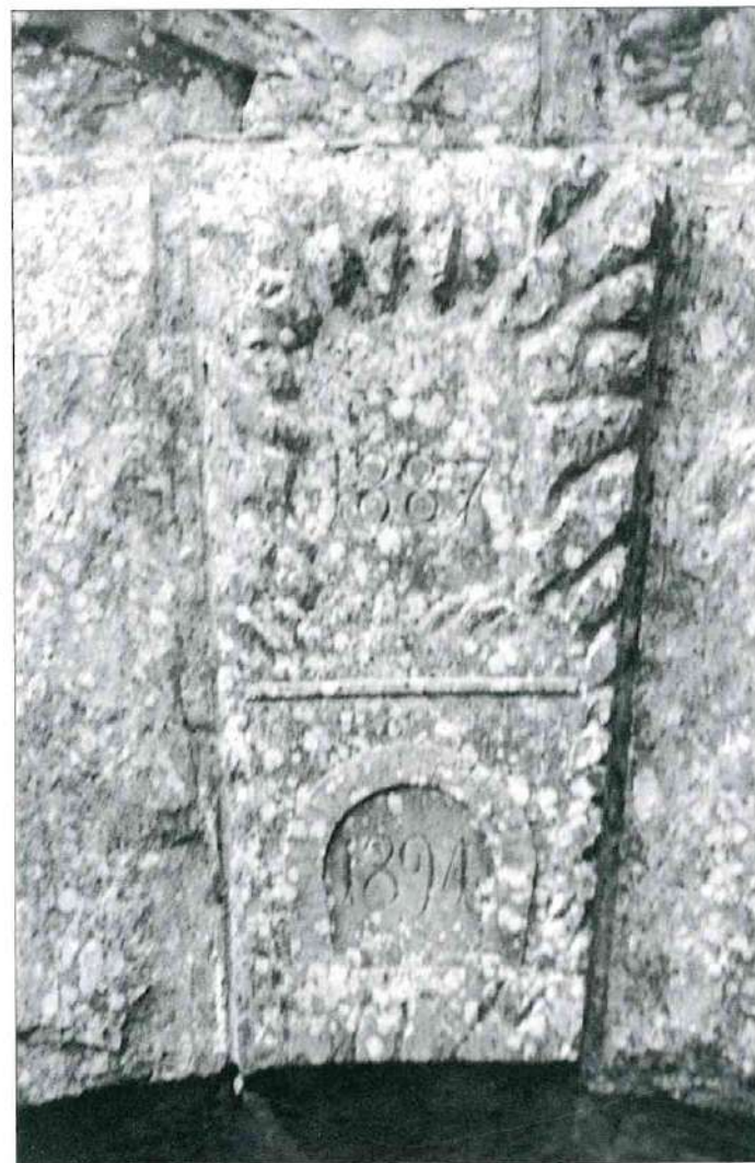
Le tunnel de la piste militaire de l'Authion à l'Arboin, au-dessus de Breil: vue de la tête côté aval et gros plan sur la pierre gravée à la clé de voûte de la tête amont. Les dates de 1887 et 1894 y figurent, dans un encadrement figurant le profil du tunnel. Photos Maurice FAYET
