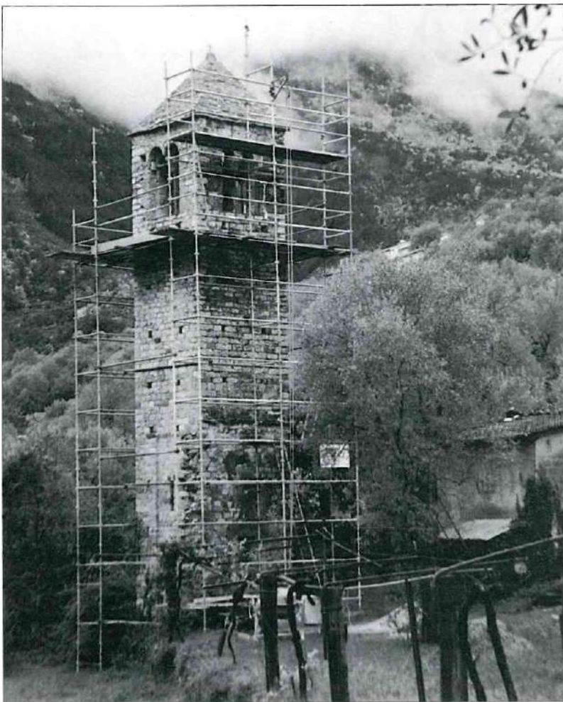
Le clocher St.Jean en cours de restauration à l'automne à Breil-syr-Roya. Photo Michel BRAUN
