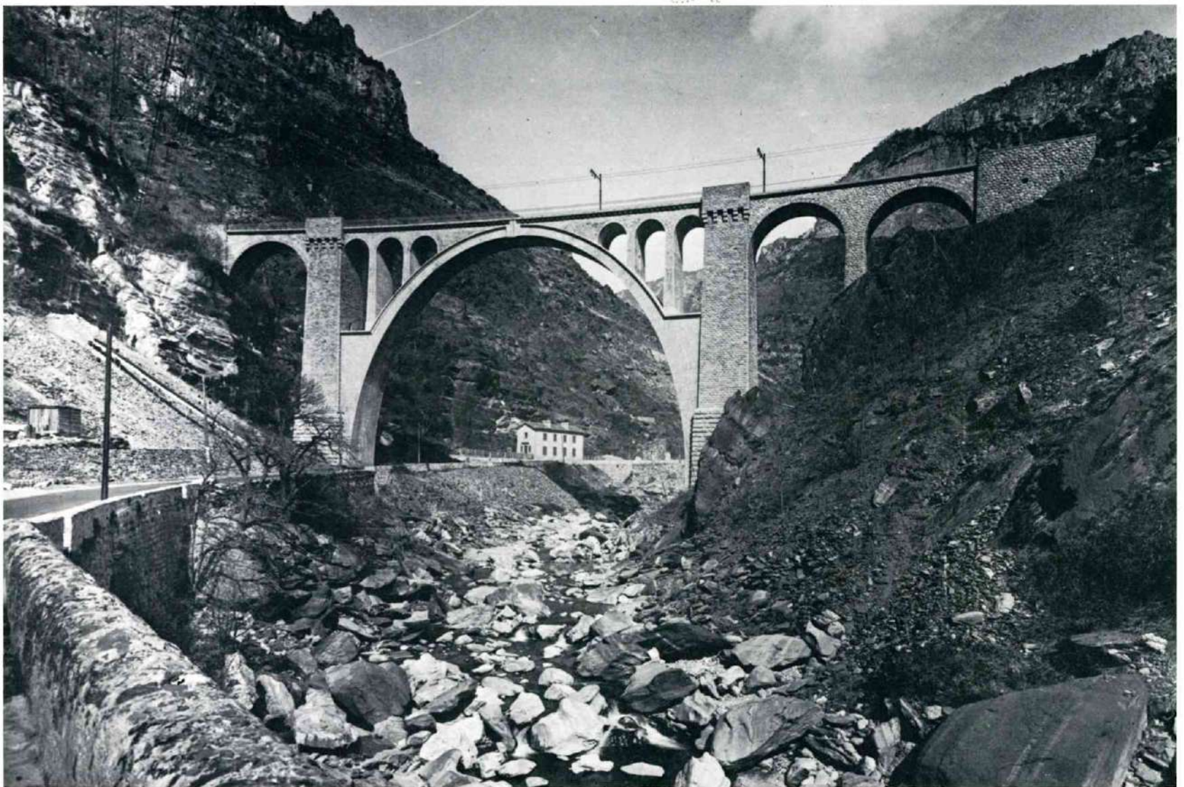
Le viaduc de Scarassouï, vu après son achèvement et l'électrification de la ligne par les chemins de fer italiens en 1935. Document S.I.E.
