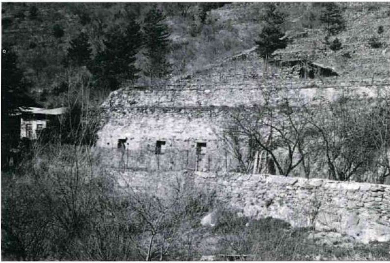
Niches à abeilles dans un mur de soutènement à La Brigue. Photo L.N. MASETTI
