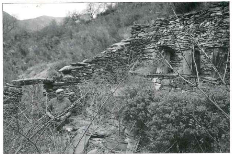
Augustin Riberi au «naijou» n°13 du Pont Riche, avec de vieux «bruschi». Photo L.N. MASETTI
