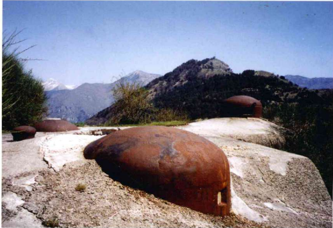
Depuis la partie supérieure de l'ouvrage du col de Brouis, la cime du Bosc et la Croix de Cougoule apparaissent à l'arrière-plan au dessus de la cloche GFM (guetteur - fusil mitrailleur) du bloc n°3. En bas, quelques graffitis laissés par les soldats allemands dans le bloc n°1 de ce même ouvrage. Photos Yann DUVIVIER
