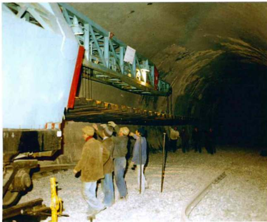
Les travaux de mise en place de la voie ferrée ont progressé de Viévolà vers Breil à l'automne 1978. Ci-dessus, un train de ballast de l'entreprise Desquenne & Giral avec la célèbre locomotive « Belphégor » en gare de La Brigue. A gauche, pose de la voie aux portiques dans la boucle de Cagnurina au dessus de Tende et ci-contre à la poutre lanceuse dans le tunnel hélicoïdal de Berghe. Photos Jacques CHAUSSARD
