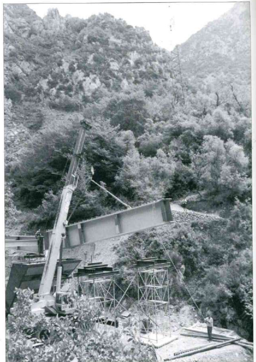
Mise en place d'une poutre du pont aval de la déviation des gorges de Saorge durant l'été 1998. Photo Etablissements Fuochi - Breil
