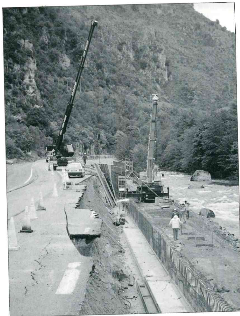
A gauche, le nouveau viaduc routier des Eboulis en construction, entre son homologue ferroviaire de la ligne Breil - Vintimille et les ponts Bailey provisoires qu'il remplacera. A droite, les travaux d'élargissement de la R.N. 204 à La Giandola, au nord de Breil. Photos Michel BRAUN
