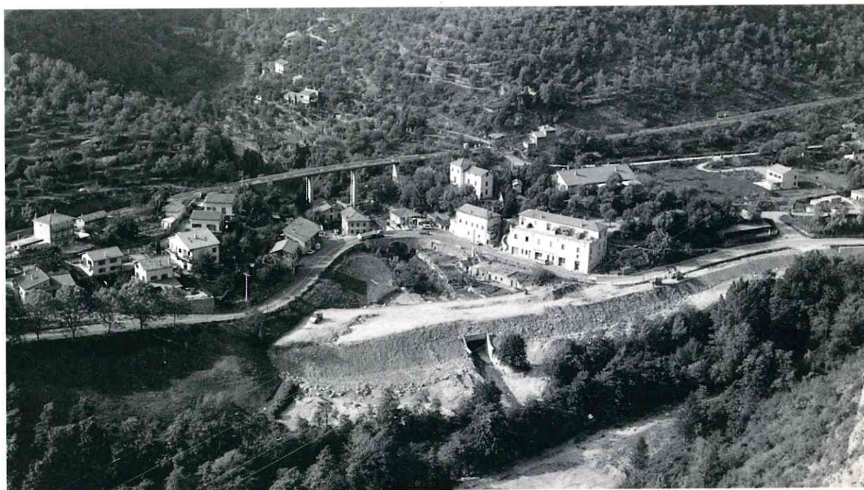
Vue générale de La Giandola en Octobre 1989. Le viaduc ferroviaire a été reconstruit une dizaine d'années auparavant, et les travaux de la déviation routière battent leur plein. Photo Charles BOTTON
