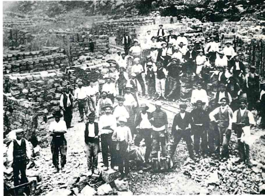
Ce remarquable et rarissime document montre la carrière de l'Agaisen en 1914, donnant un aperçu de la grande activité qui y régnait. On peut y voir des tas de pierres taillées prêtes à être descendues sur le chantier, et les voies Decauville à écartement de 0,60 m qui servaient aux évolutions des wagonnets chargés de pierres. Photo PERRIN - collection Joseph BOER
