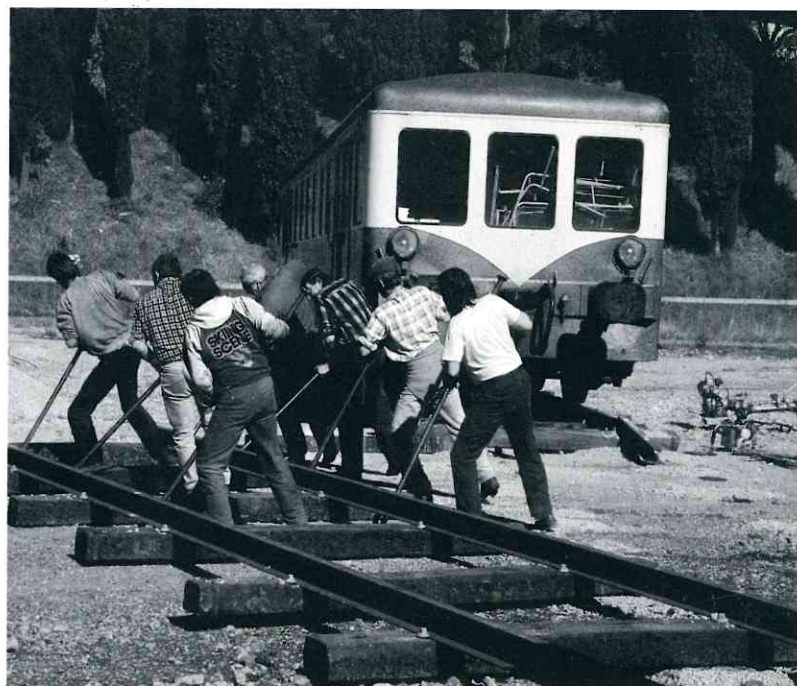
Ci-contre, la pose des voies destinées aux remorques de l'"Eco-Musée du Haut Pays" , autour de la plaque tournante de la gare de Breil-sur-Roya, en Mars 1989.
