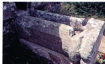
Fig. 18 - Four d'Erquy. Goulotte de sortie des boulets rougis.
