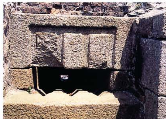
Fig. 20 - Ouverture de chargement du four de la pointe du Roselier.
