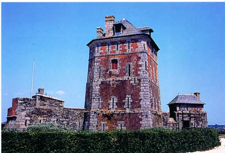
Fig. 24 - Camaret (Finistère). Tour de défense édifée par Vauban. On distingue le four à boulets sur la gauche.
