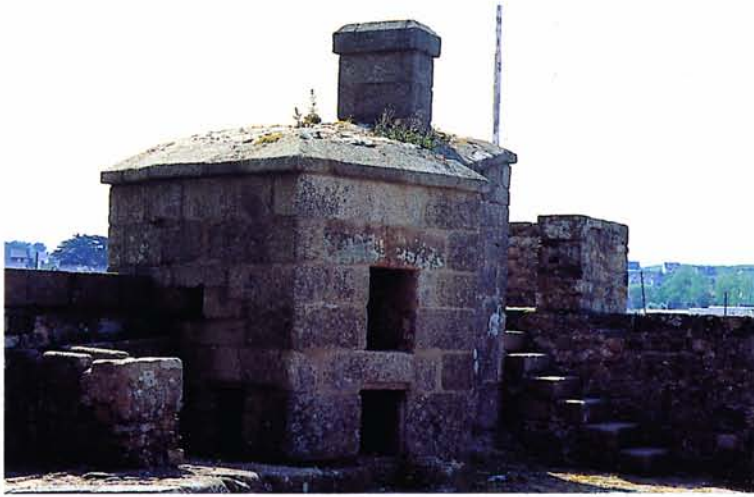
Fig. 25 - Four à boulets rouges de Camaret (Finistère).
