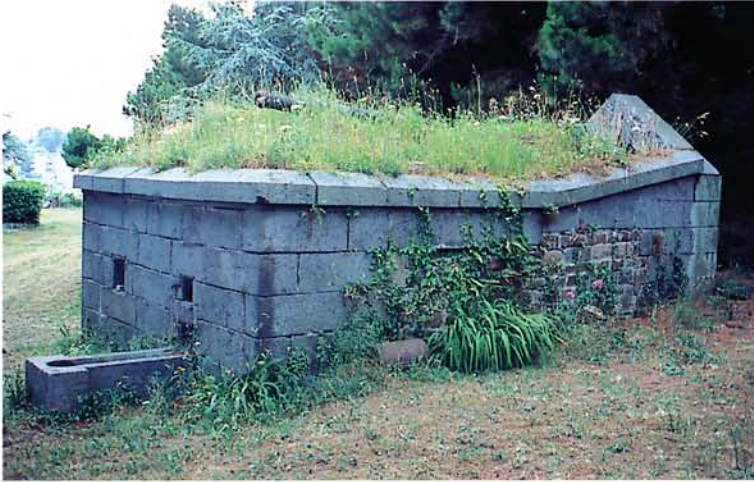
Fig. 21 - Four à boulets rouges de St-Quay-Portrieux (Côtes-d'Armor).
