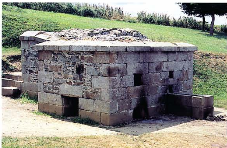
Fig. 19 - Four à boulets rouges de la pointe du Roselier (Côtes-d'Armor).
