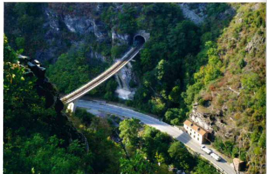
Le viaduc de Scarassouï vu du sentier valléen en rive gauche de la Roya.
