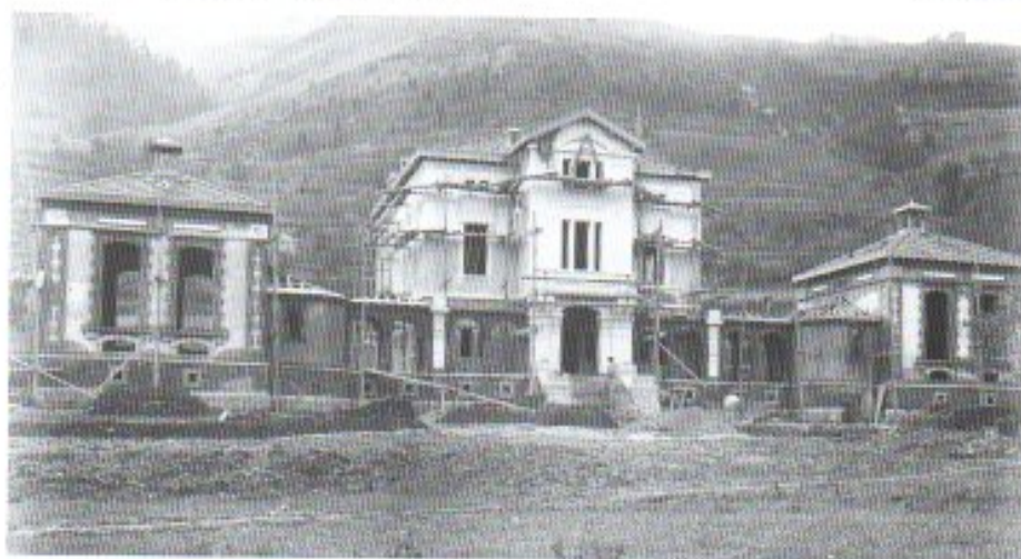
Construction de l'hôpital Bischoffheim, coll. ADAM
