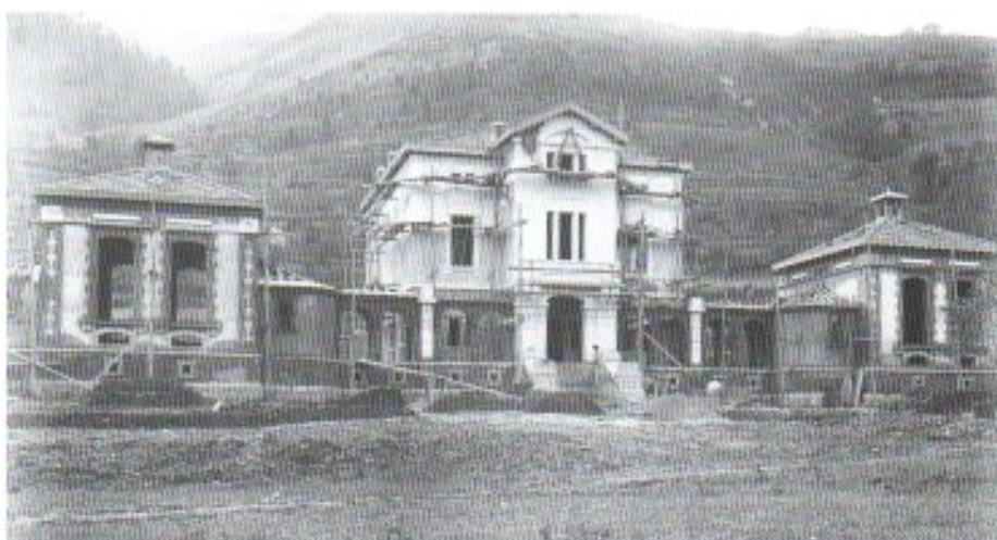
Construction de l'hôpital Bischoffheim, col. ADAM
