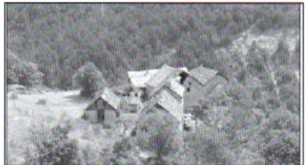
Les Laves : vue d'ensemble prise depuis l'ouest. David Faure-Vincent - ©EPR
